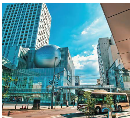
北陸新幹線の延伸によって再開発が進んだ福井駅周辺
