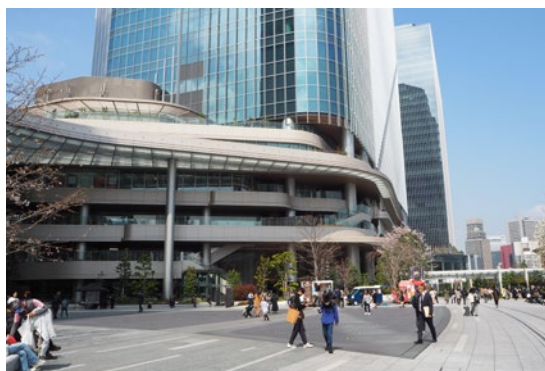
駅前に広がるGateway Park。街には5棟のビルが建ち、広場やデッキ、ピオトープなどの回遊空間が全体を一体化している。
