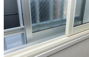
全住戸の内窓設置を実施
