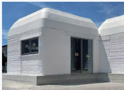
日本初の二人世帯向け3Dプリンター住宅「serendix50」。わずか44時間30分で完成。
