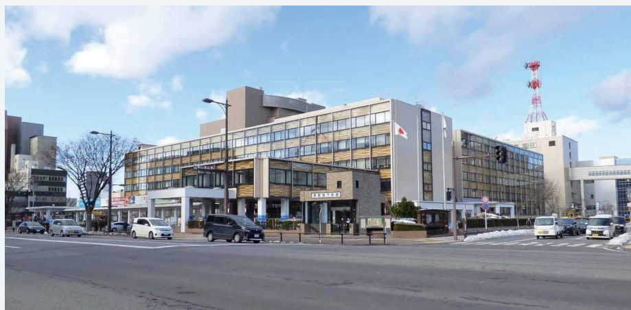
写真2:減築・改修後の青森県庁(出典:青森県庁舎耐震・長寿命化改修事業資料より抜粋) ※青森県庁の元の設計者は、東宮御所や帝国劇場などを手がけた谷口吉郎氏。
