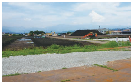
原水駅周辺の広大な敷地は150戸ほどの分譲住宅が建設される予定。
