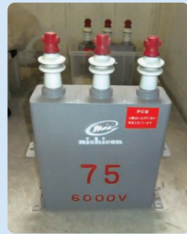
電力用コンデンサー
