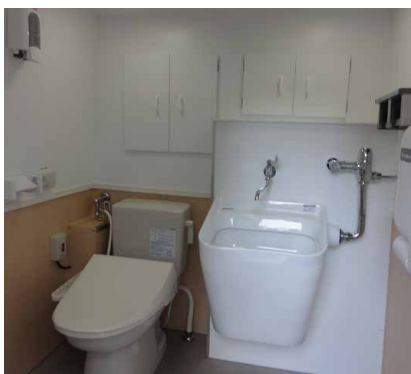
トイレカー内部
