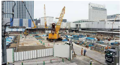
JR広島駅南口再整備・駅ビル建て替えの工事現場。従来の駅ビル「ASSE」は建て替えのため令和2年に閉館。
