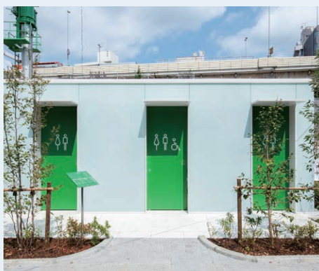
【西原一丁目公園トイレ】は建築家・坂倉竹之助氏がデザイン。端正な建物前面の通路から各個室へ直接入る。
