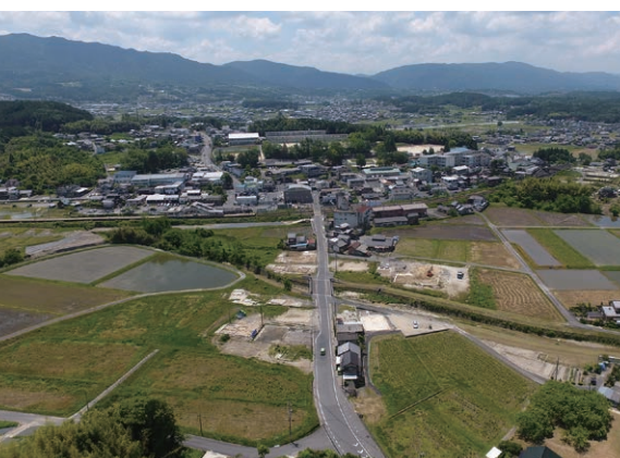
リニア中央新幹線の岐阜県駅が整備される地域・中津川市千旦林。
