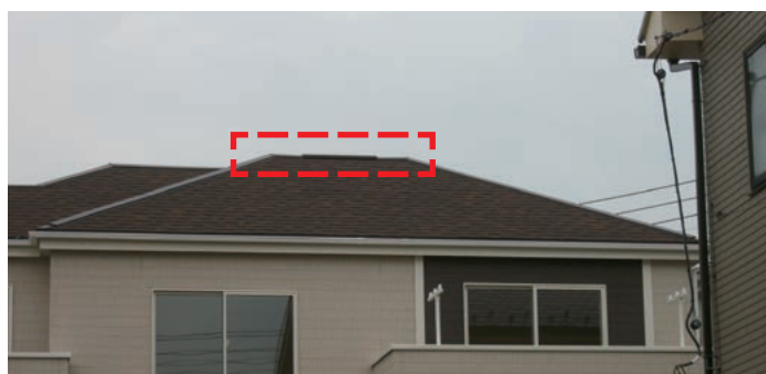
写真5 寄棟の屋根の棟部分に棟換気が設けられている(少し飛び出た部分)
