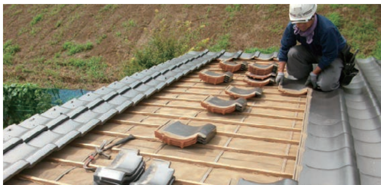
写真2 棧瓦葺きの施工の様子（葺き土を用いず、瓦棧と呼ばれる横方向の部材に瓦を引っ掛ける）
