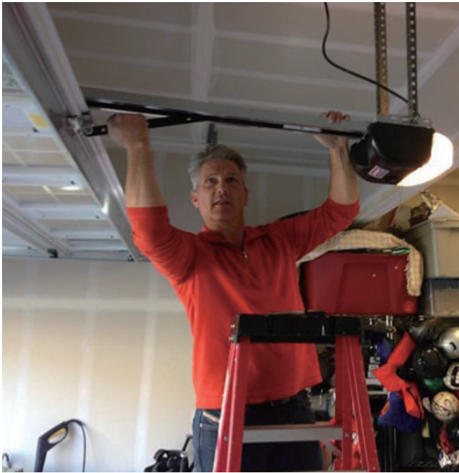
一戸建てのガレージ開閉機を動作確認するホームインスペクター
