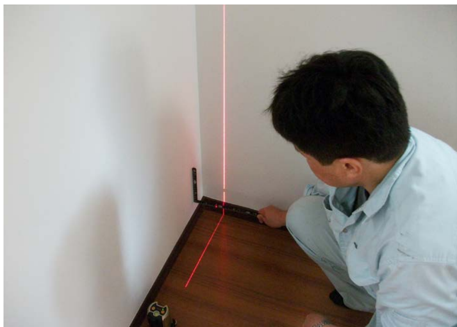
「レーザーレベル」を用いて傾斜を測定している様子
