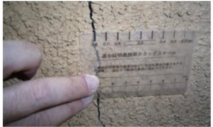
・モルタル塗りの外壁に幅0.8mm程度のひび割れが生じている状態です。
