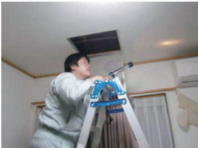
点検口からの目視（点検口の有無は事前に確認）
