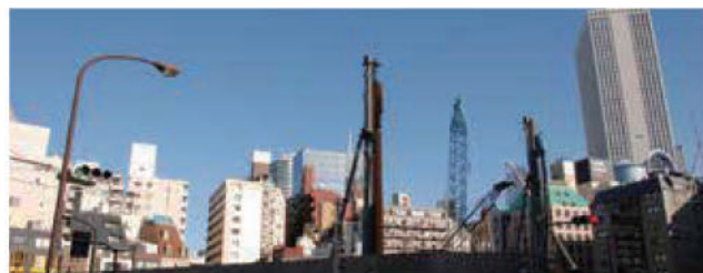
2016年12月より旧庁舎の跡地活用事業工事が着工された
