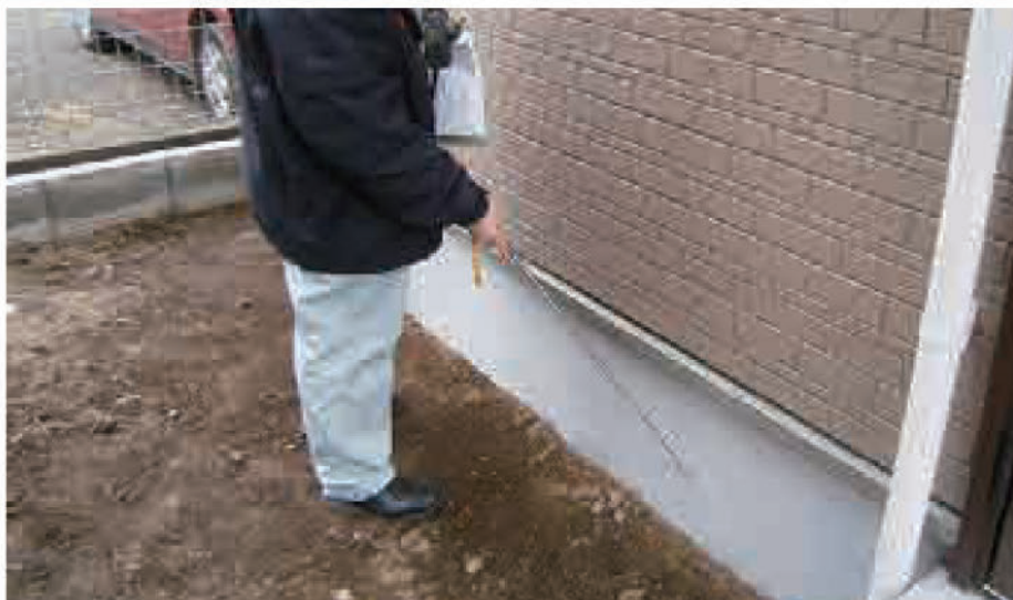
基礎を打診調査（あくまで目視・非破壊による調査）
