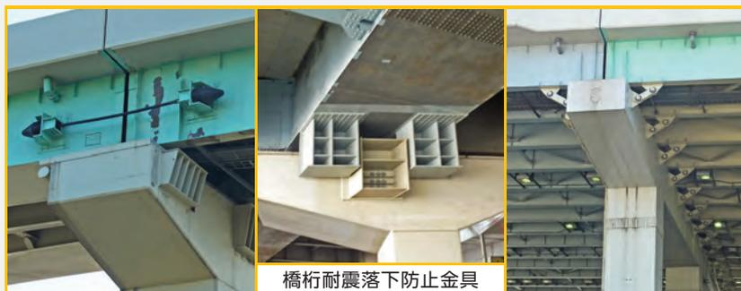
橋桁耐震落下防止金具
