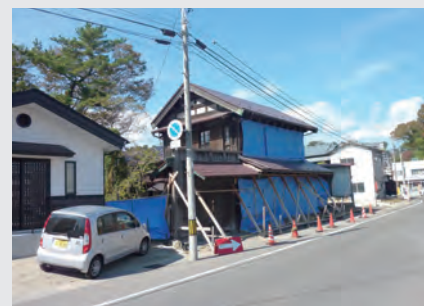
図3 補修中の民家(塩竈市)
