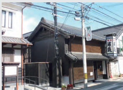
図2 木造建物に大きな被害はない(塩竈市)
