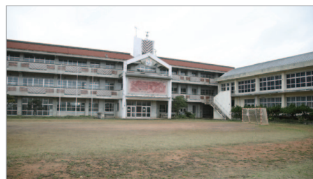
▲防火措置により、3階建ての木造校舎も建築可能に
