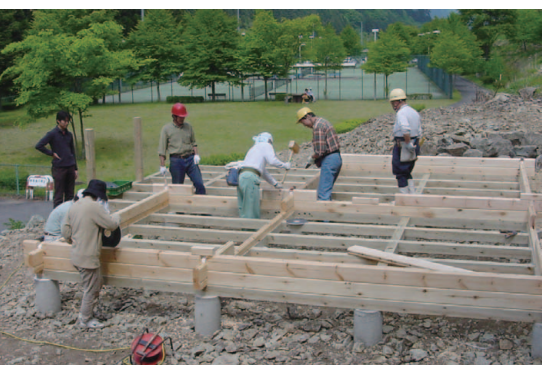
▲ログハウスをセルフビルド。写真はログ積みの様子
