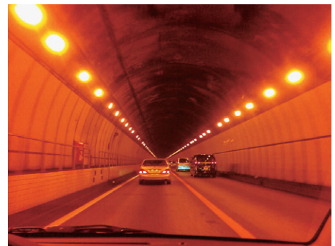
緊急点検された恵那山トンネル(中央道)
