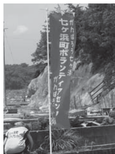
七ヶ浜町のボランティアセンターの方々が瓦礫の撤去作業を行っていた
