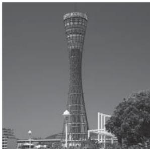
1963年に建設された高さ108mの展望用タワー。設計者は伊藤紘一・仲威雄(日建設計)。世界初のパイプ構造の建造物であり、その独特の構造・形状から「鉄塔の美女」とも称される。神戸港のシンボルとして修学旅行等の観光客が港町神戸を学習する際に立ち寄る拠点となっており、中には売店・レストラン・展望台等を設備。2010年4月、鉄塔の塗装の塗り直しや40種類のイルミネーション演出を可能としたLEDライトの設置、展望室のバリアフリー化等が施され、リニューアルオープンした。
