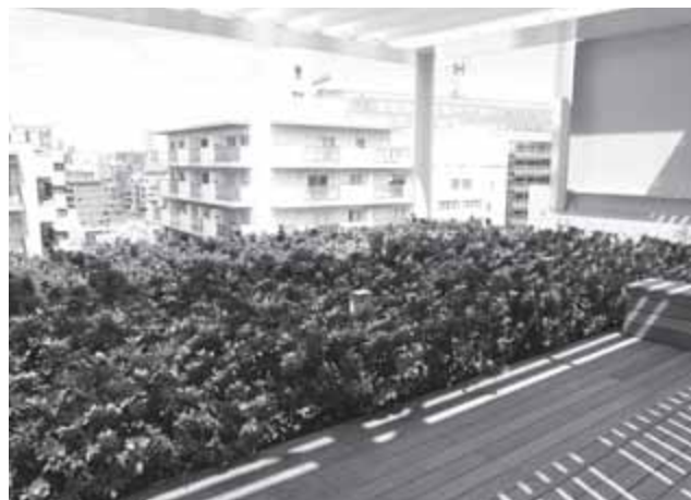
「蒲田トーセイビル」の屋上「スカイガーデン」 CASBEE Aランク認証取得のオフィスビル
