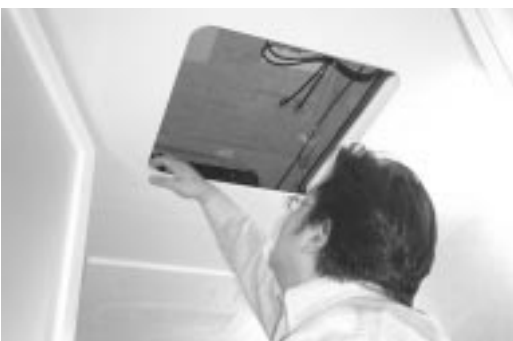
点検口から中の様子を確認。施工が雑だと、不具合が生じている場合が少なくない。カビや水漏れもチェック
