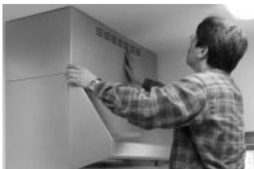
レンジフードの取付け状況を見る。排気状況も欠かさずチェックする
