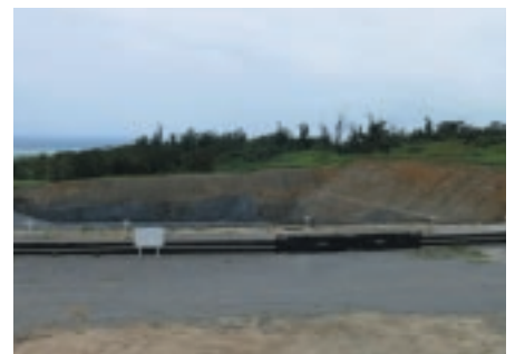
石垣新空港建設工事では、最新の工法を採用し 赤土の流出を抑え、環境への影響を最低限に留めるように工夫されている▲
