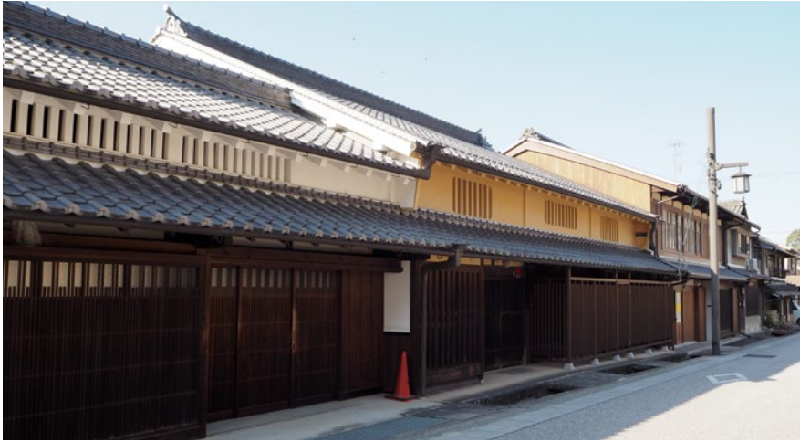
左から、江戸、大正、昭和に建てられた町家。町家の時代判定をする際、もっともわかりやすいのが「建物の高さ」で、時代が新しくなるにつれて2階部分がだんだんと高くなっていく。
