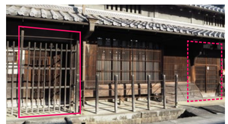
座敷玄関:宇陀の町家には複数の玄関を持つタイプがみられる。座敷玄関はダイレクトに客間や仏間につながり、冠婚葬祭の時などに利用される。日常生活と接客の空間の使い分けがよく考えられている。※赤枠が座敷玄関。点線枠が通常の玄関。
