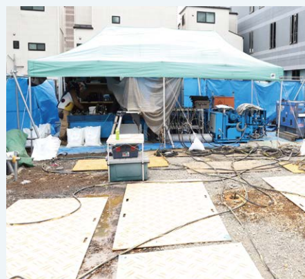
エコサイクル（株）が施工した土壌汚染対策（原位置浄化）の一例
