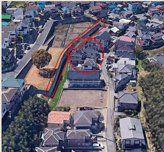
区画整理施工後の現地周辺の空中写真 長い擁壁が見えます
