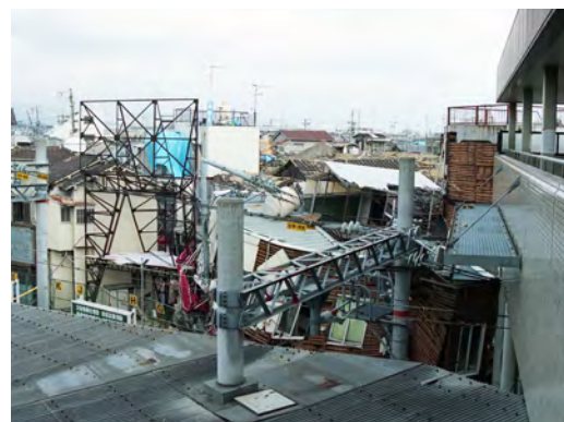
西宮北口駅北東地区の被災状況(北口町2番) 写真提供:西宮市情報公開課
