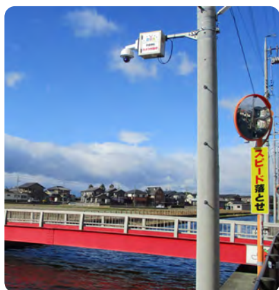
水位を撮影したカメラの映像は、CATVや専用アプリで確認できる
