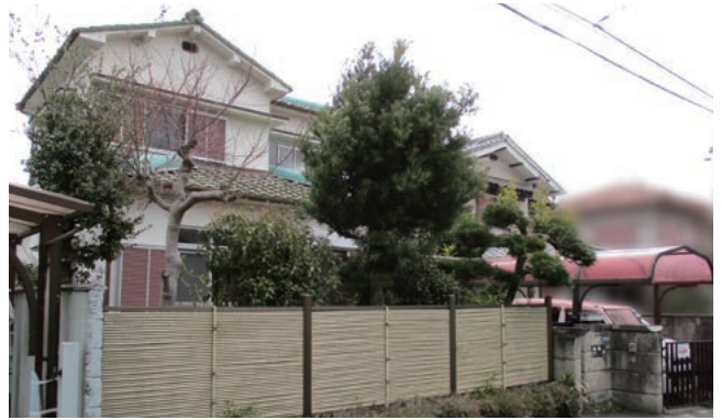
プラットフォームに提供された事例。低賃料で貸し出し、借主がDIYで修繕
