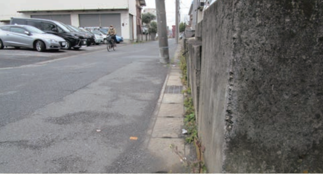
傾いているブロック塀 (写真右)
