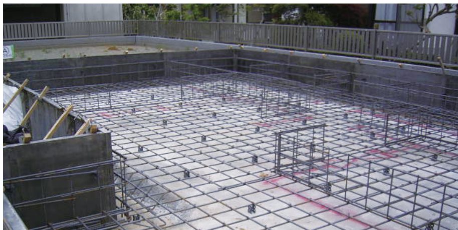
べた基礎の配筋状況。底盤部分も30 cm以下のピッチで鉄筋が配置されている
