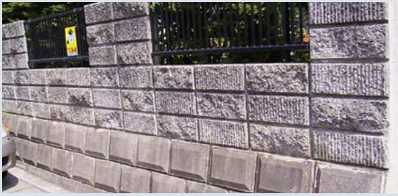
塀や擁壁を確認
