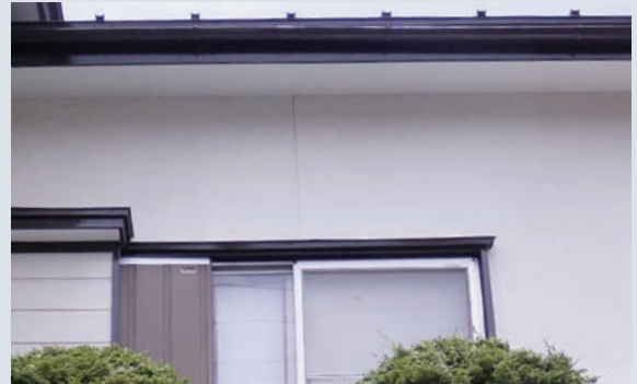
2階外壁に見られたひび割れ
