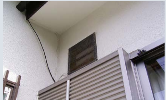
外壁を貫通する設備廻りに注意
