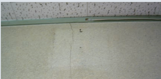
外壁と同じ場所の室内側にもひび割れがある
