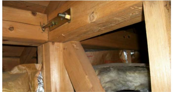
旧耐震の仕様(柱の上部に金物なし、筋交端部にもプレート状の金物なし)
