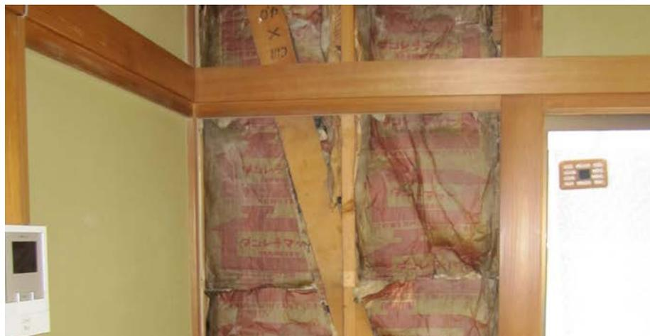
耐力壁の例(既存の壁を撤去した際、確認できた筋交)
