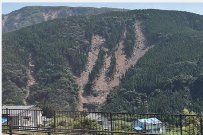
地震による崖崩れ(熊本県南阿蘇村)
