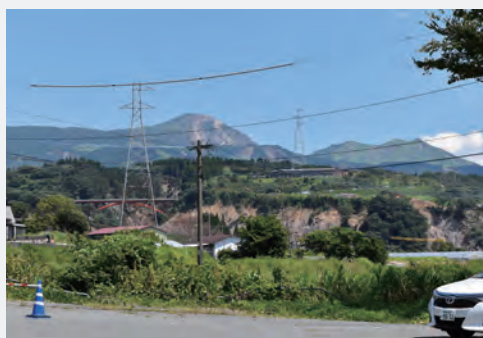
崩落した崖地(熊本県南阿蘇村)
