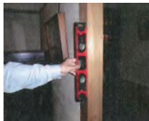
水平器による柱の傾きの計測
