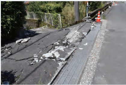
道路に入った亀裂(撮影:不動産経済研究所)
