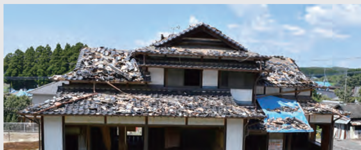
▲屋根荷重の大きな住宅の被害(撮影：不動産経済研究所)
