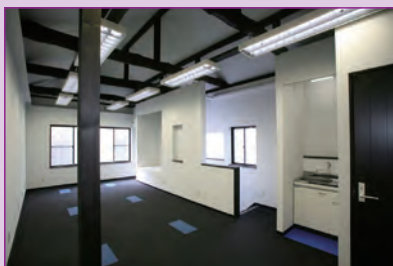
2階は梁を見せることで天井高を高くしたオフィス仕様
