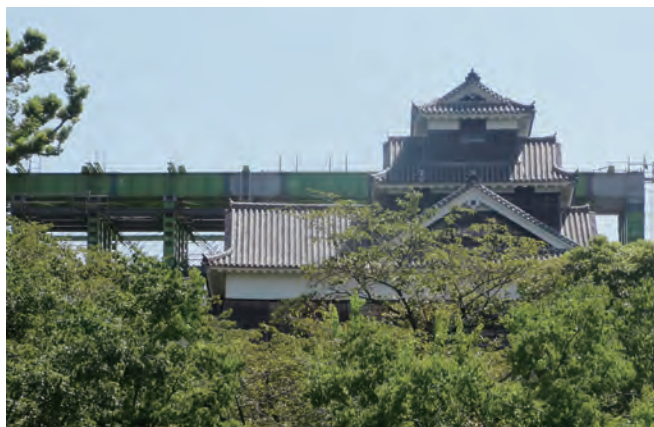
倒壊の危機にある熊本城飯丸五階櫓を支えるアーム状の鉄骨
