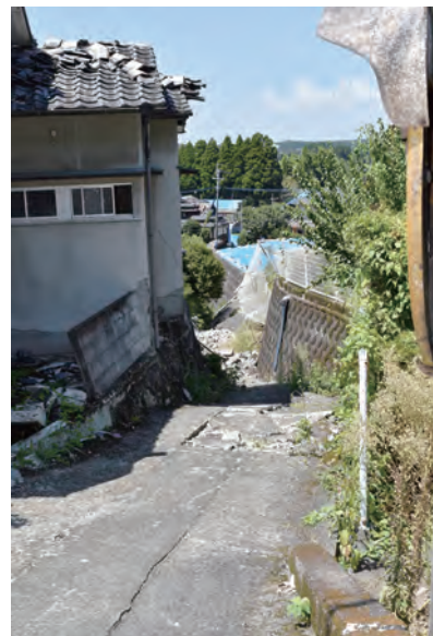
道路や擁壁にも大きな亀裂が入った
