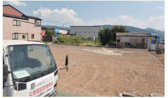
解体が終わり、すでに更地になっているところも
