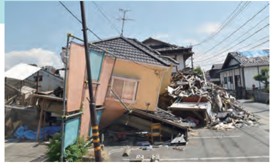
地震発生から4ヵ月たっても復旧はなかなか進んでいない
