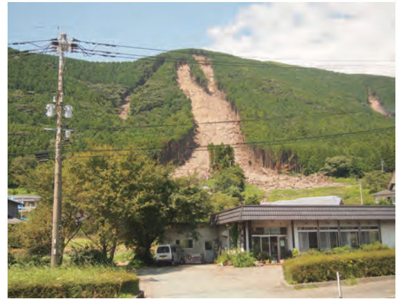
地震後の集中豪雨によるがけ崩れによって大きくえぐられた山肌
