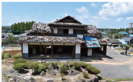
行政が解体費用を負担することになっているが、その解体も順番待ちとなっている
