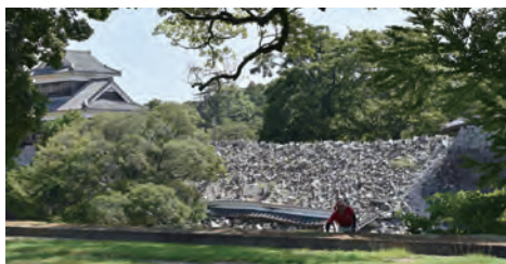
(左)地震によりしゃちほこや瓦が落ちてしまった天守閣
