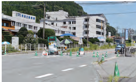
通行止めとなっている国道57号線
