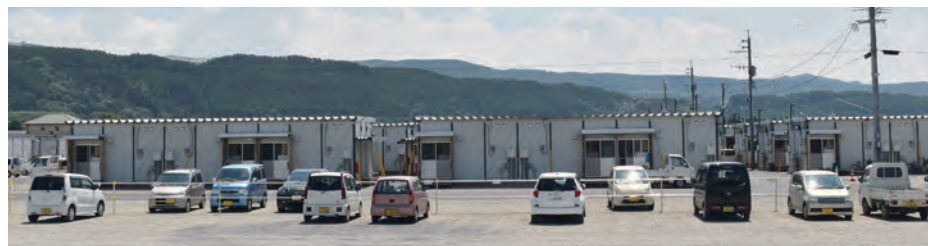
西原村の近くに建設された仮設住宅
