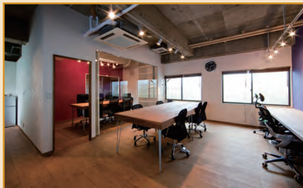
天井板を取り払って空間を広く見せる工夫
