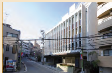
右側の白い建物が住商混在地域にある賃貸オフィス「チャリ千駄ヶ谷」
