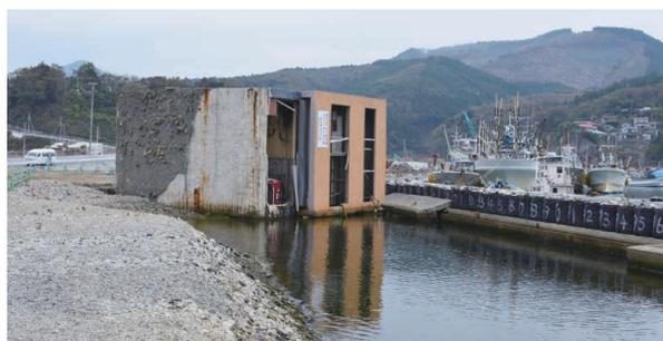
基礎部分が地面から抜けて横倒しになった鉄筋コンクリートの建物
