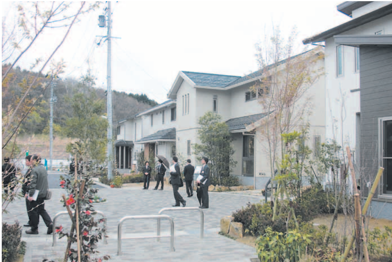
積水ハウスの「スマートコモンシティ明石台」で公開された「グリーンファースト ハイブリッド」街区の様子。建物だけでなく、道路配置や外構、植樹など街の景観づくりにも力が注がれている
