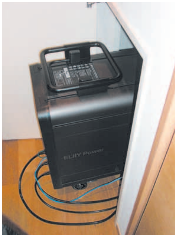
大和ハウスが採用している小型のリチウムイオン蓄電池。室内設置タイプで階段下に収納するなど場所を選ばないのも特徴
