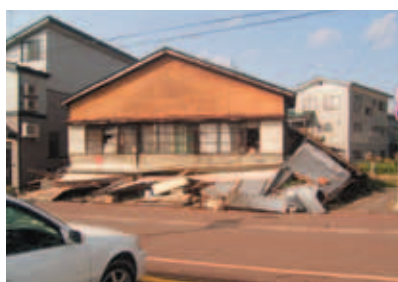
2004年の新潟県中越地震で被災した家屋
