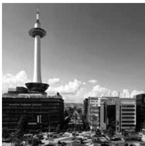
1964年12月完成。9階建てのビルの上に立つ円筒形の独特な姿は、海のない京都の街を照らす灯台をイメージしたもの。厚さ12~22mmの特殊鋼板シリンダーを溶接でつなぎ合わせ、鉄骨は一切使っていない。設計は京都大学工学部建築学教室。我が国で初めてモノコック構造を採用し他の建築物がもつ設計安全率を2倍以上も上回る値で設計したため、これまでの大きな台風や地震にも耐え、あの阪神大震災の被害も受けなかった。展望室は地上100m。京都の街を360度楽しめ、晴れた日には大阪まで見渡せる。
