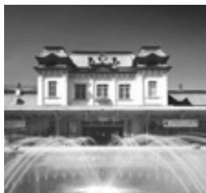
○表紙写真(日本の駅舎シリーズ) 福岡県 門司港駅
