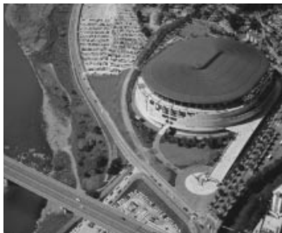
グリーンドーム前橋
